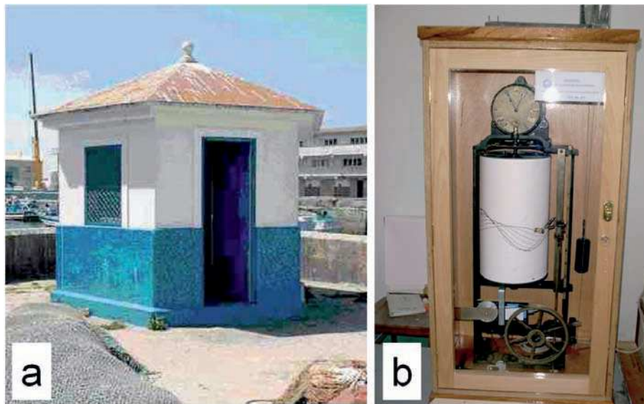
Figura 3.1. Ejemplo del equipamiento de las estaciones mareográficas: caseta de la estación de Vigo (a) y mareógrafo mecánico de flotador con codificador (b).
